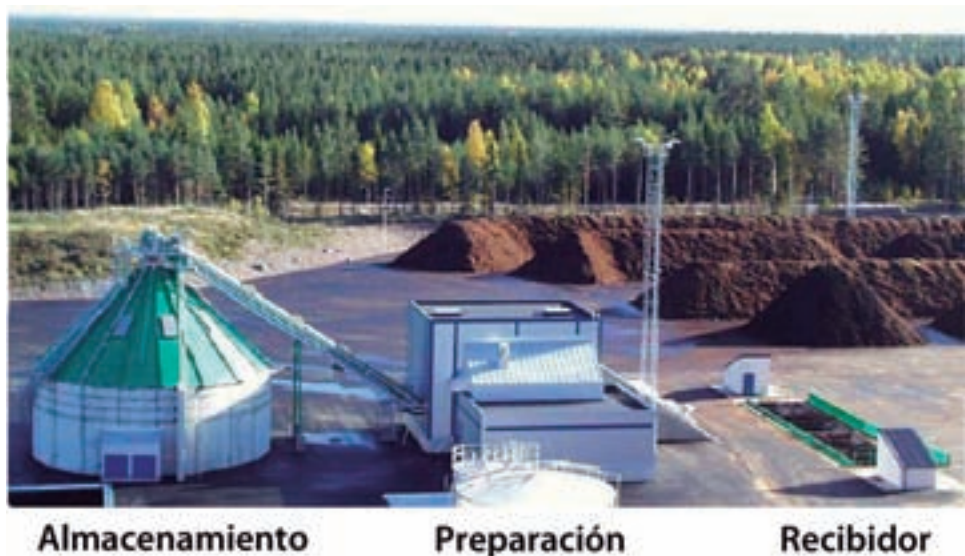
Figura 3.2 Fotografía de la secuencia de manipulación externa de la biomasa mostrando las operaciones: recepción de la biomasa, preparación del combustible y los silos de almacenamiento.
