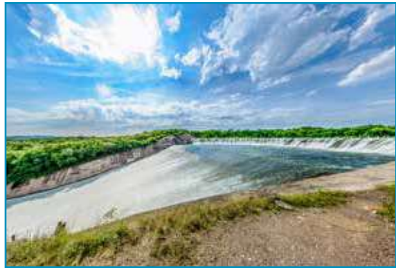
Planta hidroeléctrica de Sanalona, Sinaloa.
