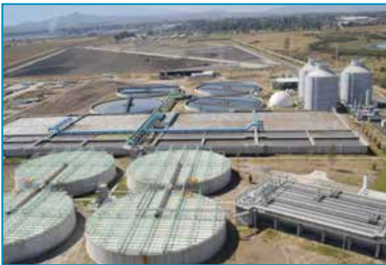
Planta de biogas El Ahogado, Jalisco.
