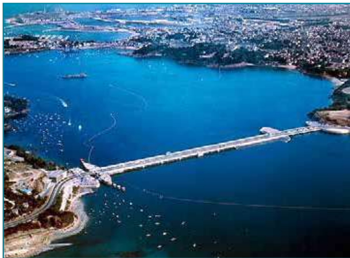
Figura 6. Central maremotriz de 240 MW. La Rance, Francia
