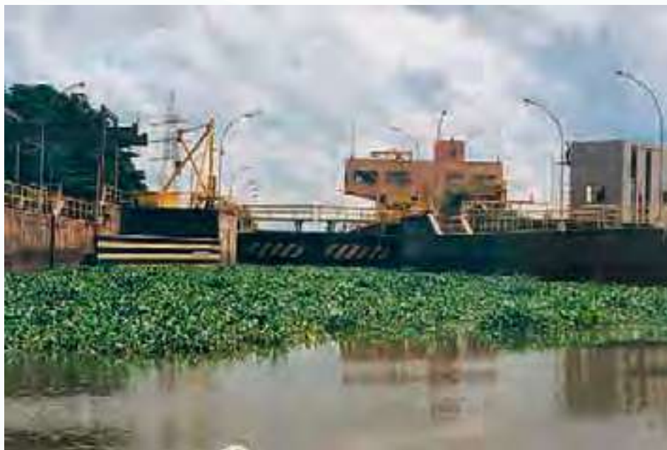
Figura 2. A eutrofização de reservatórios como a Represa de Barra Bonita pode interferir no funcionamento de eclusas e turbinas. Fotografia: J.G.Tundisi.
