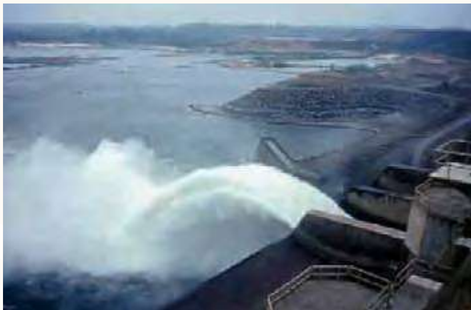
Figura 1. Vertedouro da barragem de Tucuruí, no rio Tocantins, Estado do Pará. Água sai do reservatório a uma profundidade de 20 m, onde carrega grandes quantidades de metano. A pulverização em gotículas libera este gás de efeito estufa para a atmosfera, contribuindo para o aquecimento global (Fotografia por Philip M. Fearnside).
